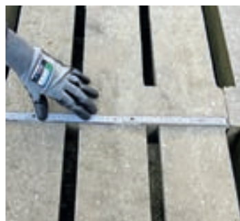
Der Spaltenboden wird vermessen.
