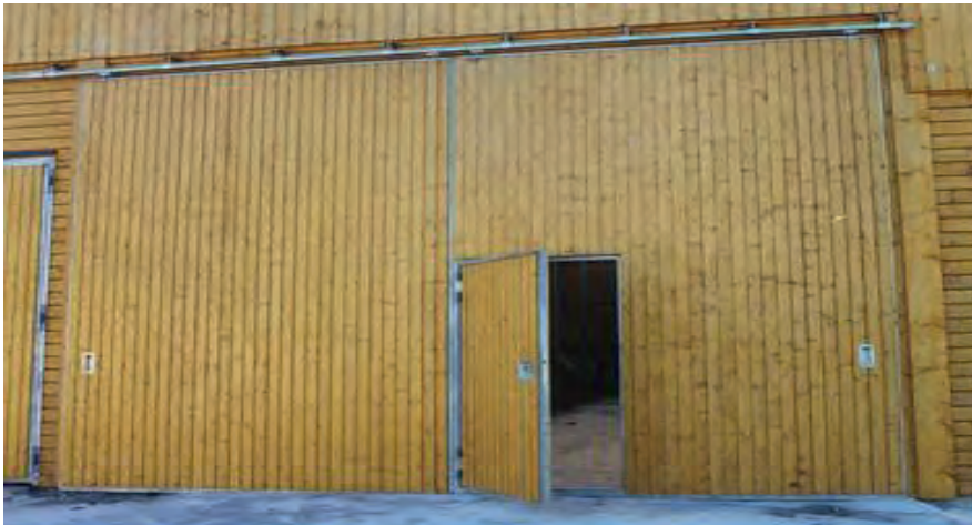
Schubtor mit geschlossenem Laufwerk und Schlupftüre
