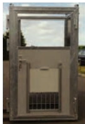
Fenstereinbau in PVC-Tür und Lüftungsgitter
