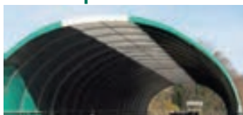
Plane mit 2,50 m breitem Lichtband am First.
