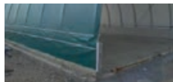
Überlappung bei Montage auf eine Mauer/Betonformsteine
