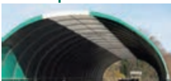
Plane mit 2,50 m breitem Lichtband am First.
