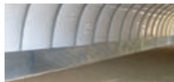
Schutzblech an der Innenwand seitlich und hinten 0,90 / 1,70 / 2,50 m hoch
