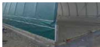
Überlappung bei Montage auf eine Mauer/Betonformsteine
