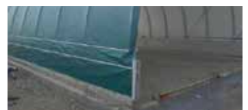
Überlappung bei Montage auf eine Mauer/Betonformsteine
