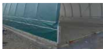
Überlappung bei Montage auf eine Mauer/Betonformsteine
