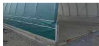
Überlappung bei Montage auf eine Mauer/Betonformsteine
