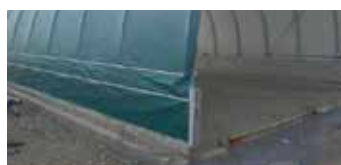
Überlappung bei Montage auf eine Mauer/Betonformsteine
