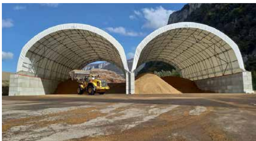
Bis zu 4 m Höhe durch Montage auf Betonfundament oder Betonformsteine gewinnen.
