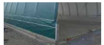
Überlappung bei Montage auf eine Mauer/Betonformsteine
