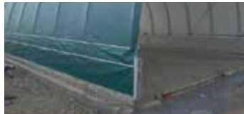
Überlappung bei Montage auf eine Mauer/Betonformsteine
